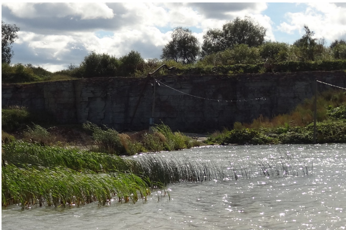
Foto 2. Säilitamisele kuuluv veetaseme regulaator karjääri lõunaosas koos tasandamist vajava nõlvaga
